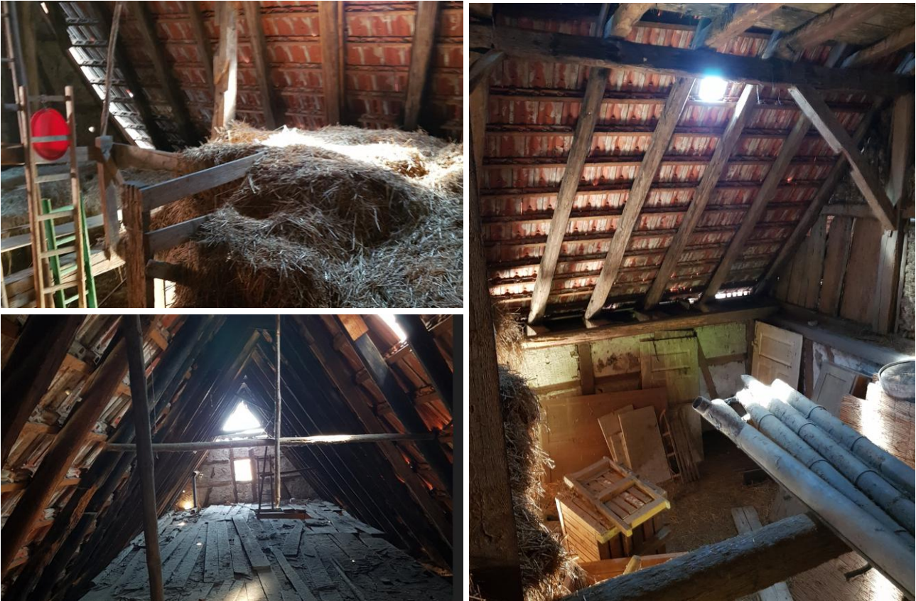
Abb. 9: Scheune und Dachboden Obere Straße 12
