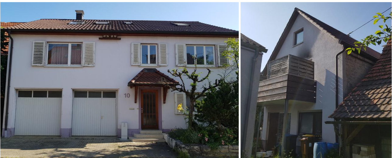
Abb. 3: Außenfassaden des Hauptgebäudes Obere Straße 10
