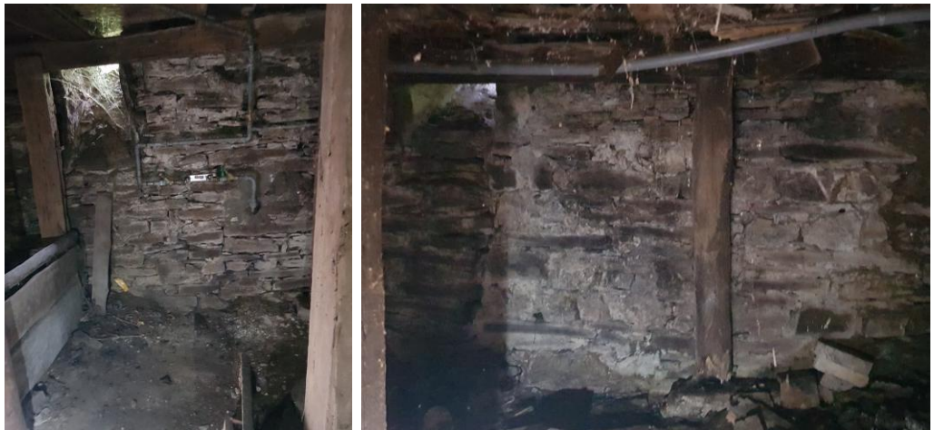
Abb. 8: Keller Obere Straße 12
