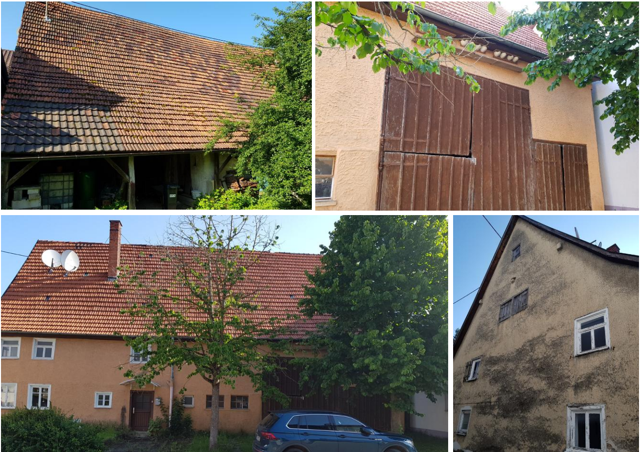
Abb. 7: Außenfassaden des Gebäudes Obere Straße 12
