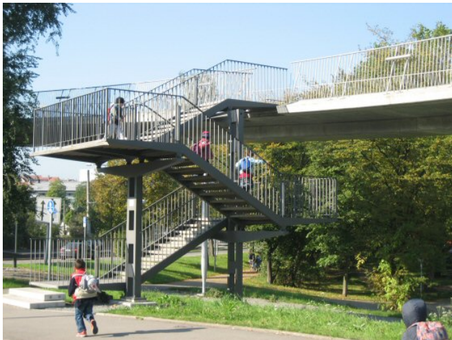
2 Beispiel: Treppe Bahnhof
